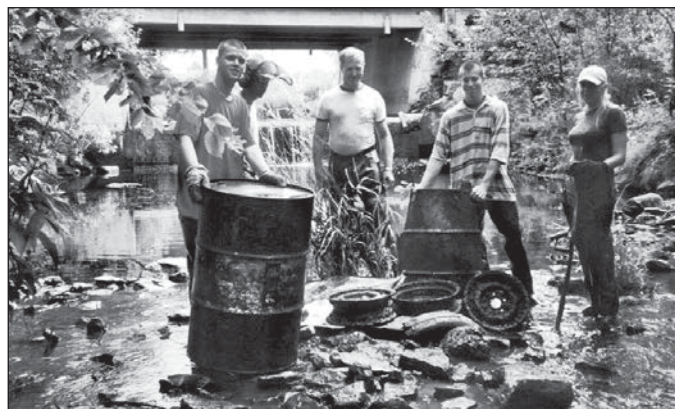
Photo 19 : Travaux de nettoyage
