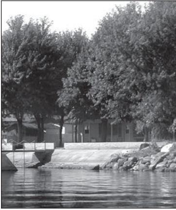
Photo 5: Faîte du mur utilisé pour déterminer la ligne des hautes eaux
