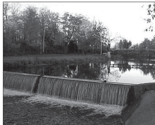
Photo 27 : Ligne des hautes eaux, en présence d'un ouvrage de retenue, correspond à la cote maximale d'exploitation
