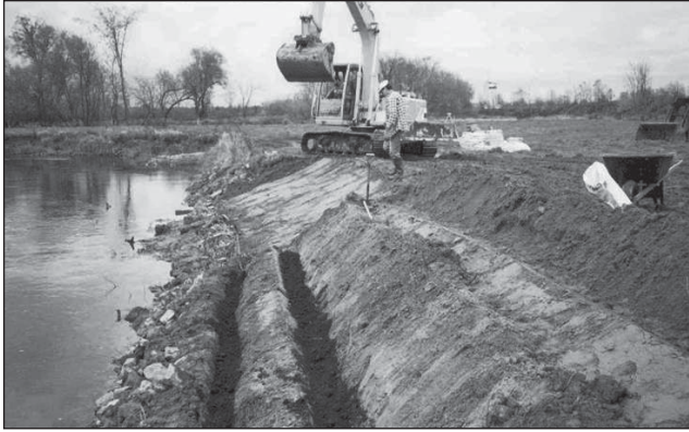
Photo 15: Travaux de stabilisation des rives : installation de fagots en bas de pente
