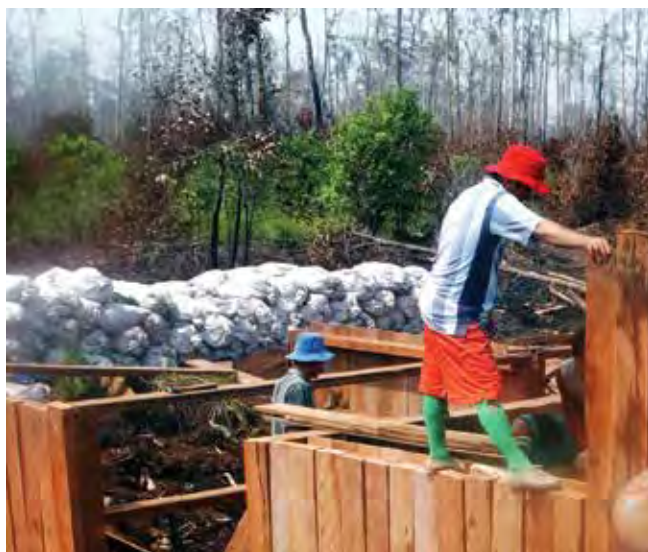
Parc National de Sebangau, Kalimantan central, Indonésie : Le WWF a construit un barrage sur le canal pour augmenter le niveau d'eau et l'humidité du sol des tourbières. © WWF-Indonésie/Hendry
