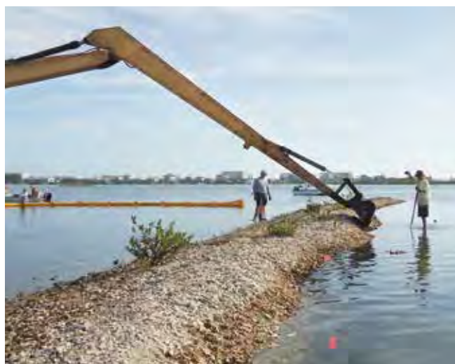
Une pelleuse dans le Mosquito Lagoon : L'objectif global du projet est d'augmenter la couverture des récifs d'huîtres intertidaux vivants en nivelant les bordures mortes et en y recouvrant les coquilles de tapis d'huîtres, un substrat stable pour le recrutement des huîtres. © Anne P. Birch, The Nature Conservancy
