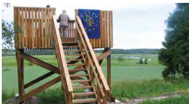
Les tours d'observation des oiseaux sont des éléments centraux pour la gestion de l'accès et de l'expérience des visiteurs dans les zones humides restaurées. © Villina Evokari
