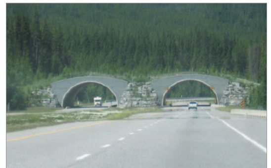
Figure 55 : Passage aérien, Alberta.
